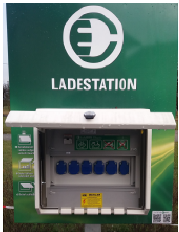
Für Fahrräder etc. stehen sechs 230-V-Schukostecker zur Verfügung.
