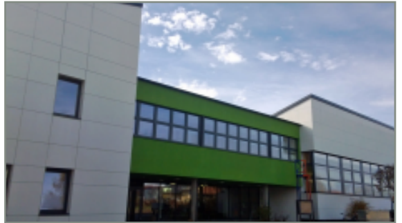
Neue Mittelschule: Außenfassade fertig gestellt. Im Dezember wird auch der Trunsaal zur Benützung frei gegeben.
