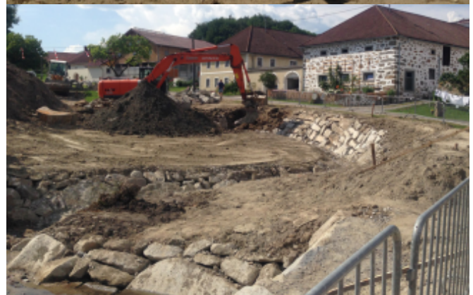
... sowie "offizieller" Spatenstich zum Hochwasserschutzprojekt in Kerschbaum.
