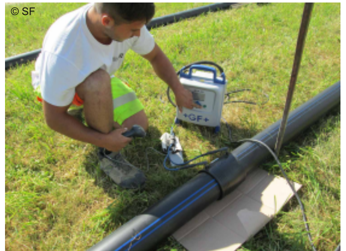
© SF Elektroschweiß-Muffen verbinden alle gängigen PE-Rohre und Stutzenfittings schnell und zuverlässig.
